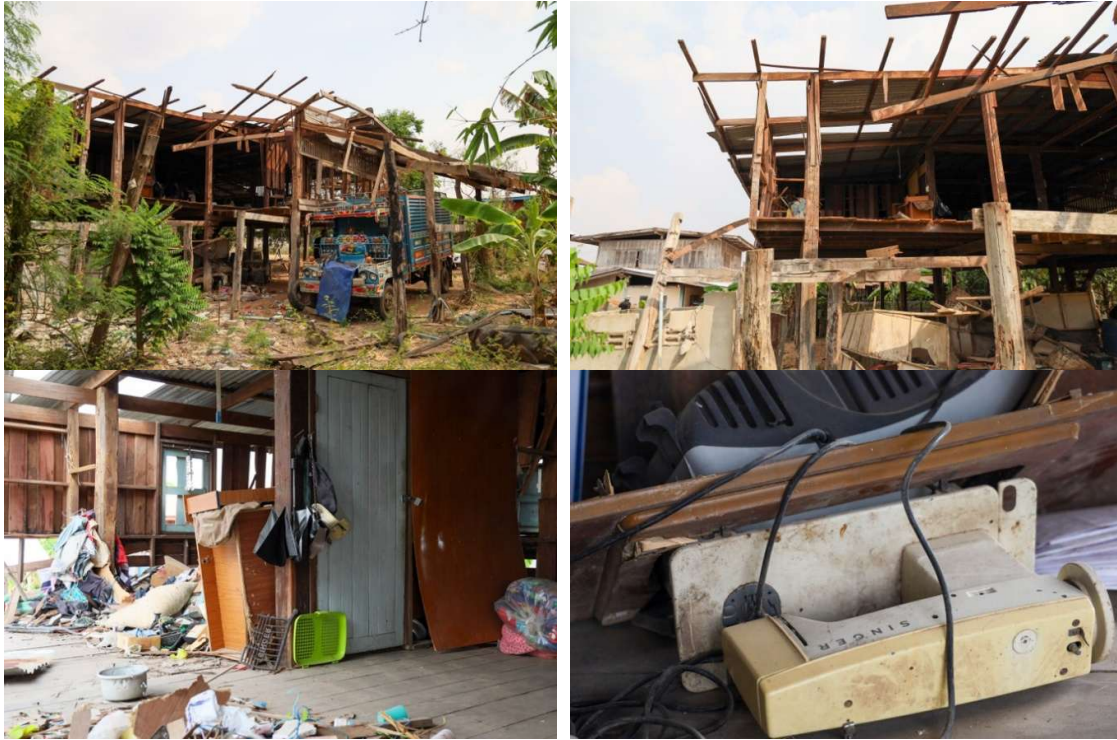
ภาพสภาพความเสียหายของบ้านคุณแม่นกน้อยจากเหตุระเบิดของจรด BM 21 เมื่อวันที่ 22 มกราคม 2569
